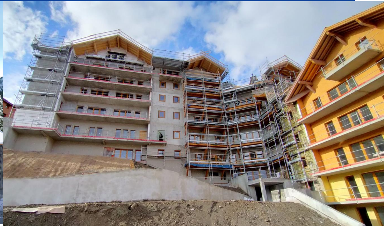
Vue du chantier à mi octobre 2022
